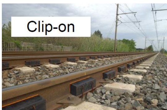
Figura nr 4: Amortizor de zgomot CORUS, aplicat
