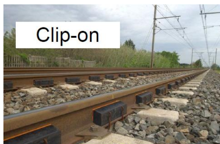
Figura nr 2: Amortizor de zgomot CORUS, aplicat
