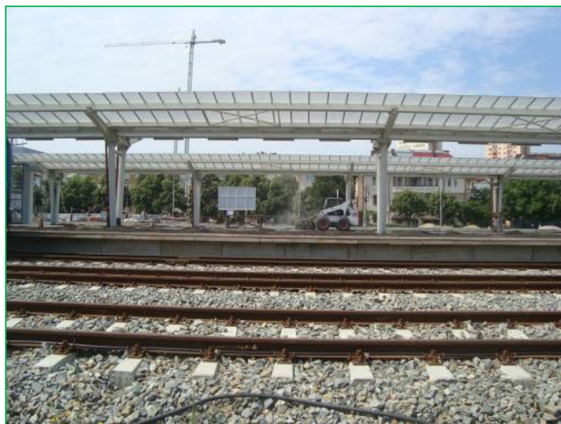
Peroane – Frezare asfalt
