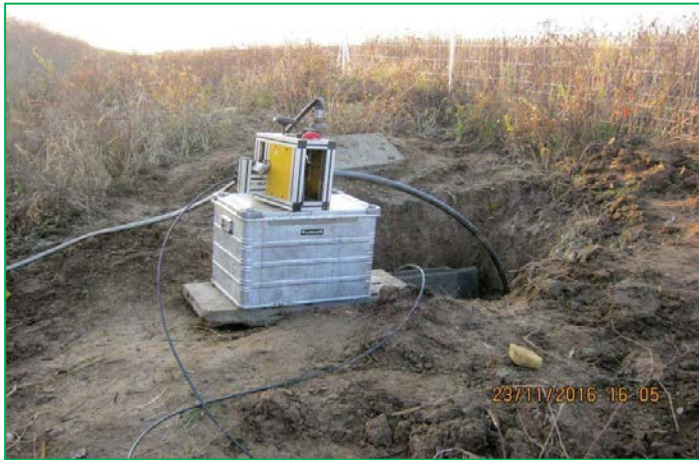
Dispozitiv pentru suflat cablu cu FO distanța Cliciova - Mănăștur
