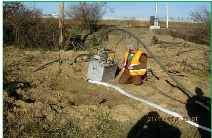
Lucrări de instalare cabluri cu fibre optice
