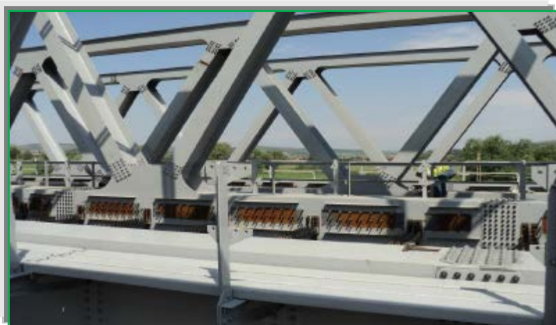
Montaj tabliere nr.2 și nr.3 pe palei provizorii
