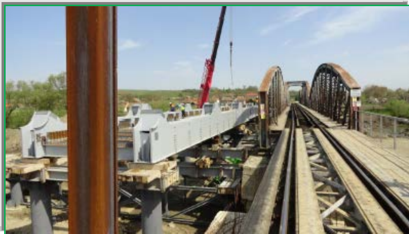
Montare tablier L=63 m pe palei provizorii
