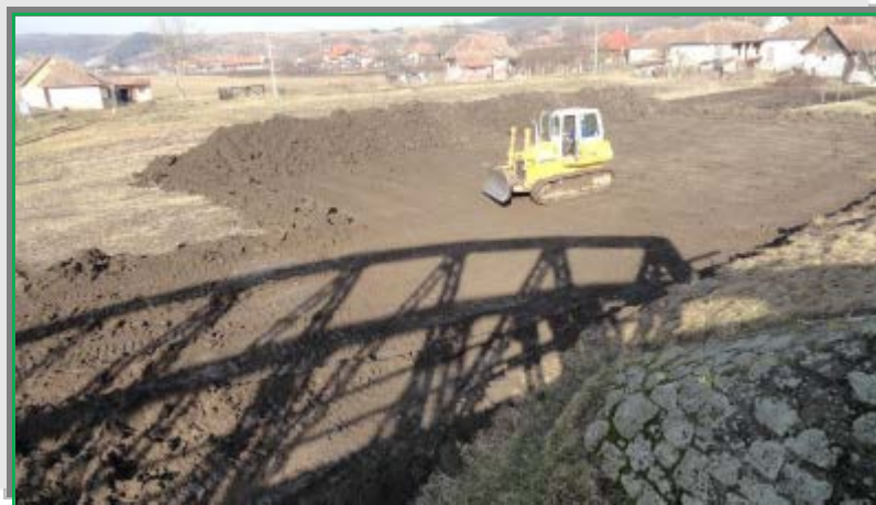
Execuție platformă de lucru - mal drept Bogata
