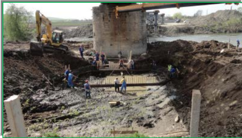
Lansare cuțit cheson - Pila I Bogata
