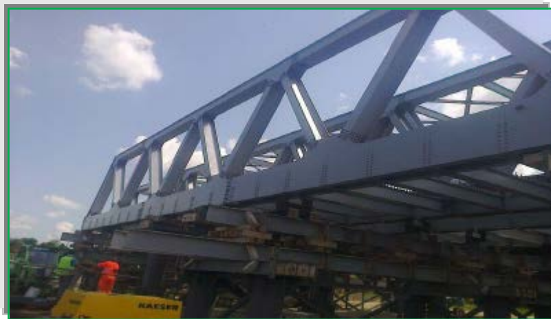
Montaj tablier nr.3 pe palei provizorii – mal Luduș
