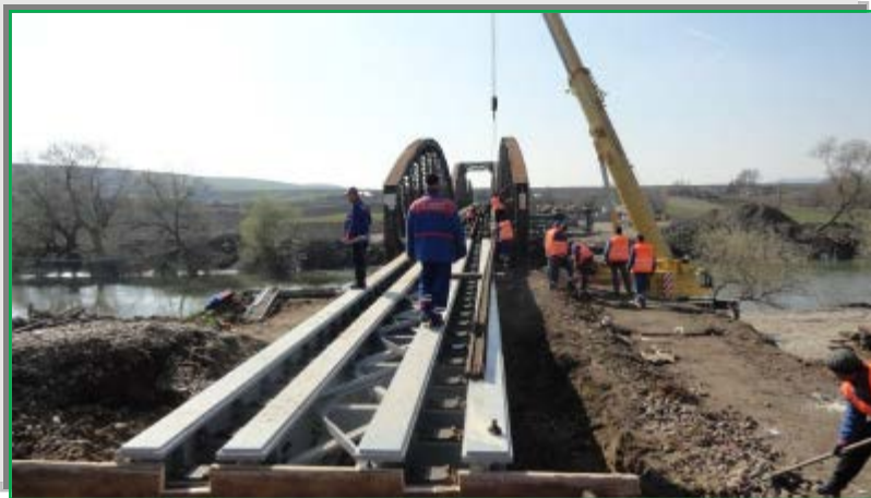
Introducere în cale pod provizoriu G18, mal Bogata
