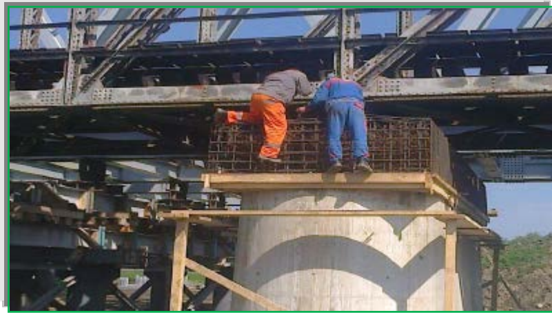
Armare banchetă cuzineți - Pila II Luduș
