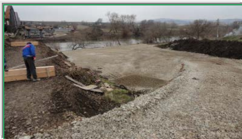
Execuție platformă și rampă de acces - mal drept Bogata
