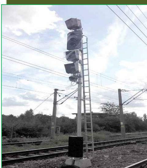
Lucrări exterioare – Instalații CE – Semnale
