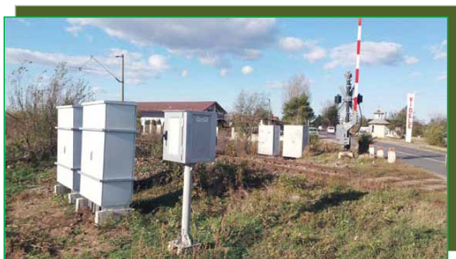
Dulapuri noi instalație BAT
