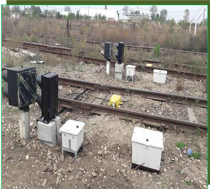
Lucrări exterioare – Instalații CE – Testare Semnale
