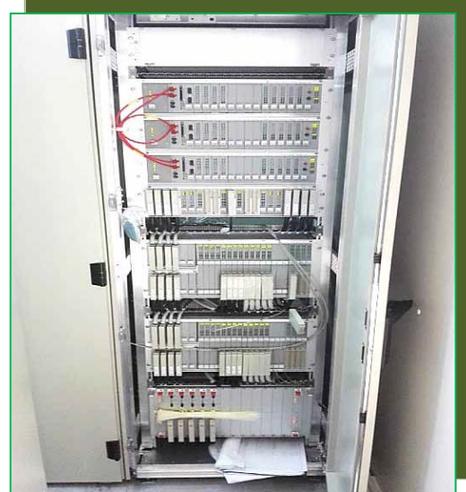
Lucrări interioare – Instalații CE – testare
