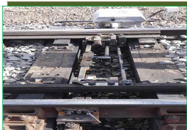
Lucrări exterioare – Instalații CE – Macaz
