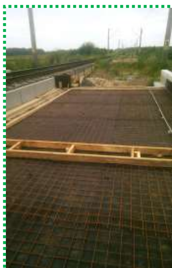
Tabliere Linia I betonate - opritori de balast armati si cofrati
