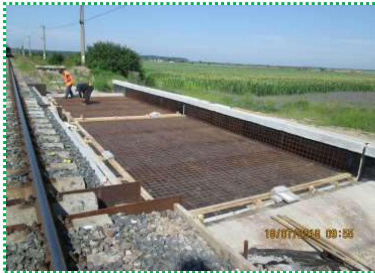
Tablier Linia I - montare armatură în șapa de protecție a hidroizolației și turnare beton
