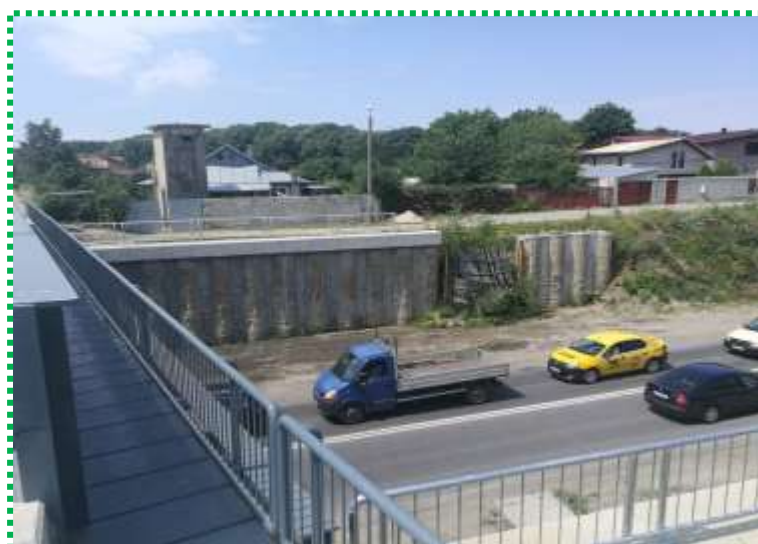
Zona aripă –în execuție
