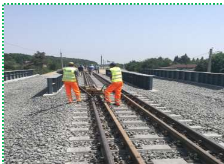
Montare Linia 700 pe pod
