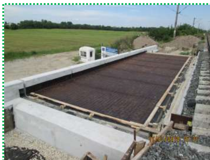
Tablier Linia I - montare armatură în șapa de protecție a hidroizolației și turnare beton
