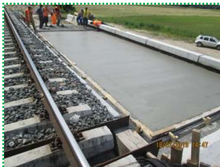
Tablier Linia I - montare armatură în șapa de protecție a hidroizolației și turnare beton
