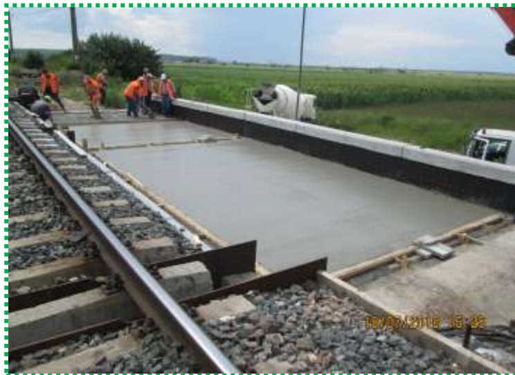
Tablier Linia I - montare armatură în șapa de protecție a hidroizolației și turnare beton
