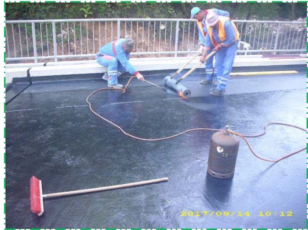
Aplicare hidroizolație
