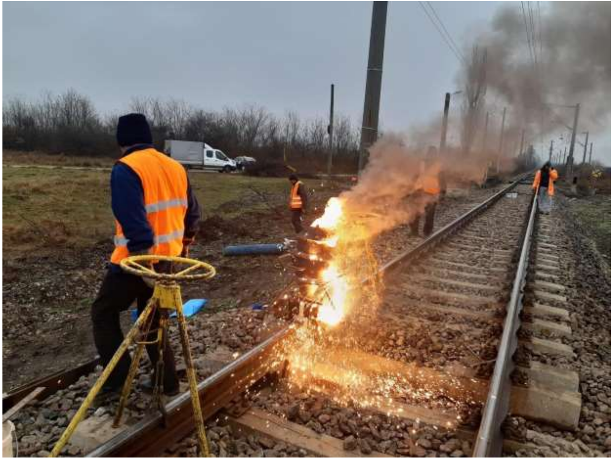
Lucrări de sudură aluminotermică între stațiile Jena - Găvojdia
