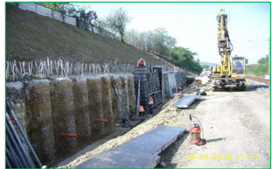
km 458+870 - 458+918 - Execuție zid mască
