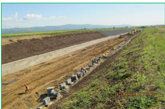
km 451+300 - 451+900 - Execuție zid de pământ armat
