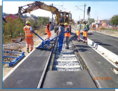
Ațel – Mediaș - montare trecere la nivel
