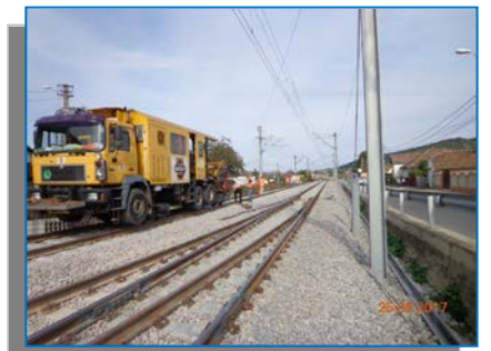
St. Mediaș - sudura șinelor
