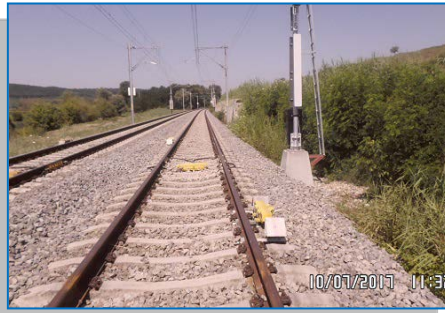
Valea Lungă – instalare cameră
