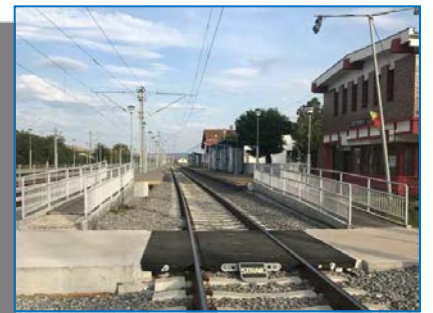
Stația Crăciunel – trecere la nivel
