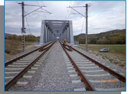
Pod 8 - montare contrașine
