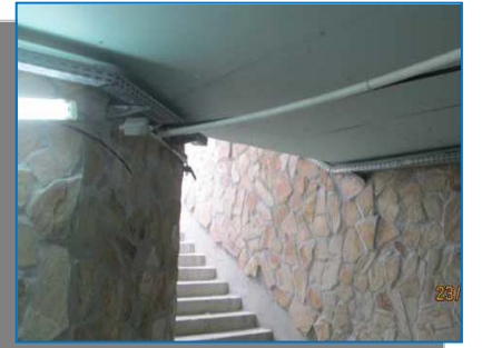
Stația Blaj - tunel pietonal
