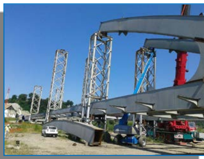
Pod 1 - montaj elemente componente pod arc
