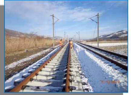
Montare suprastructură CF
