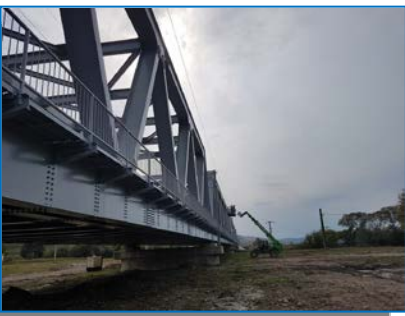
Pod 8 – remediere vopsea
