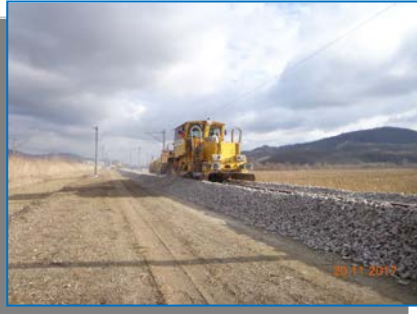
Copșa Mică - Micăsasa - buraj, profilare, stabilizare
