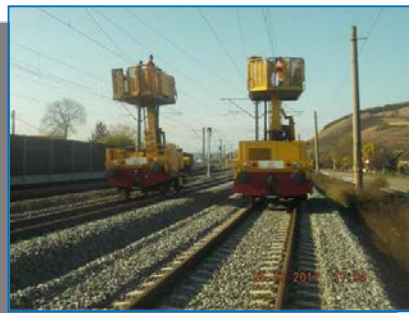
Stația Valea Lungă - derulare fir de contact
