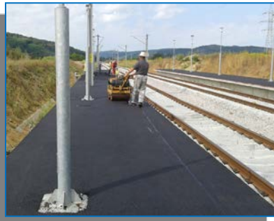
P.O. BRATEIU – asfaltare peron
