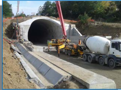
Tunel Sighișoara – ieșire
