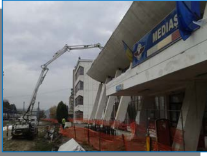
St. Mediaș - reparații acoperiș clădire călători
