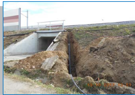
Mediaș – protecție cabluri pe poduri și podețe
