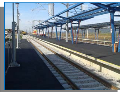
Staţia Daneş – asfaltare peron
