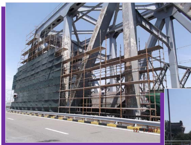
Schele pentru sablare și protecție anticorozivă
