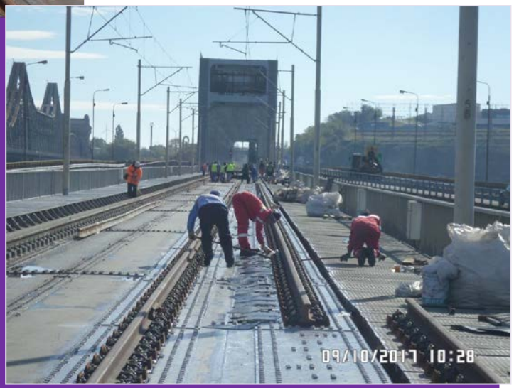
Lucrări de linii
