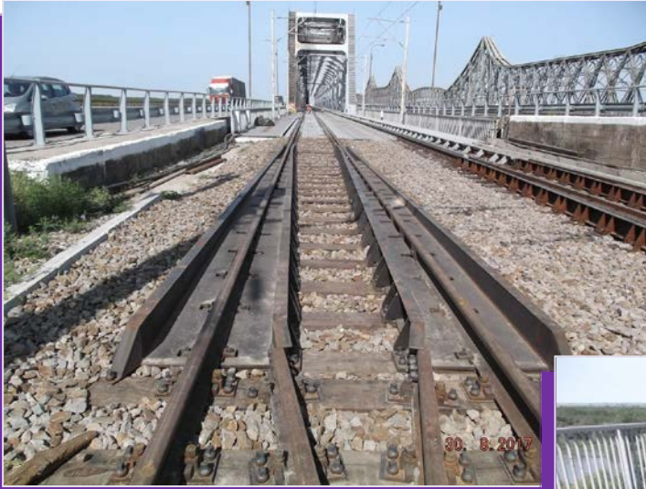
Lucrări refacere terasament la capetele podului
