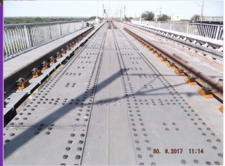
Lucrări de linii și consolidare
