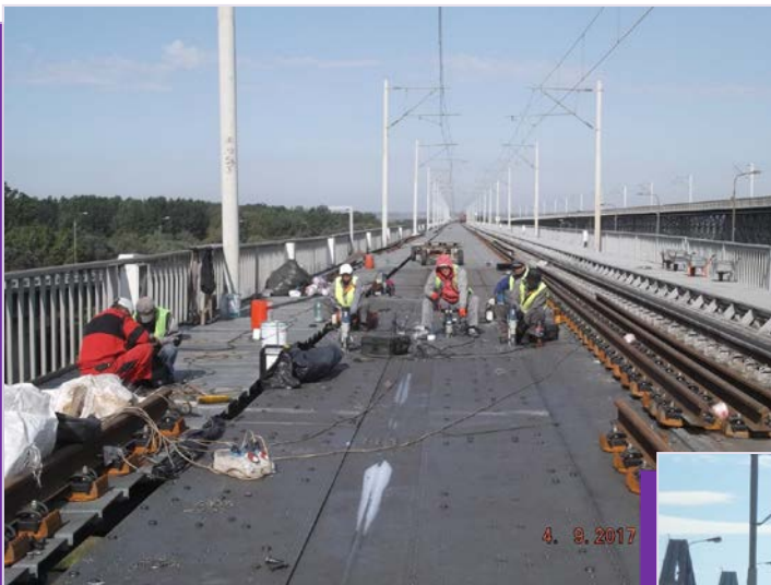
Lucrări de linii și consolidare
